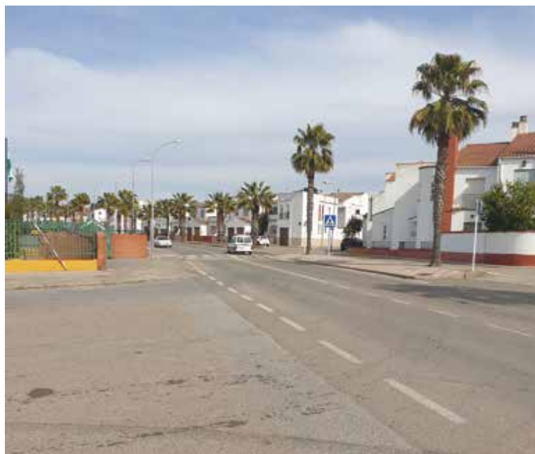
Tramo de la vía que se va a solicitar a la Junta su arreglo
