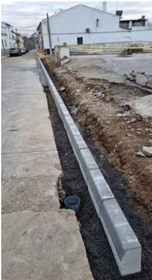
Trabajos que se han iniciado en la calle Fernando III el Santo
